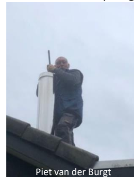
Piet van der Burgt bezig met het vegen van de schoorsteenpijp
